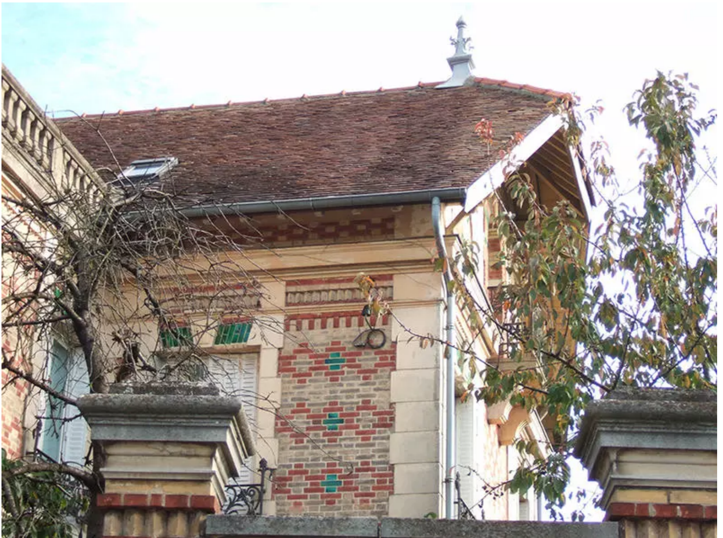
Maison répertoriée dans l'inventaire du patrimoine réalisé par le CAUE du Val-de-Marne pour la ville de Boissy-Saint-Léger © CAUE 94
